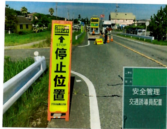
写真-2 片側規制状況
